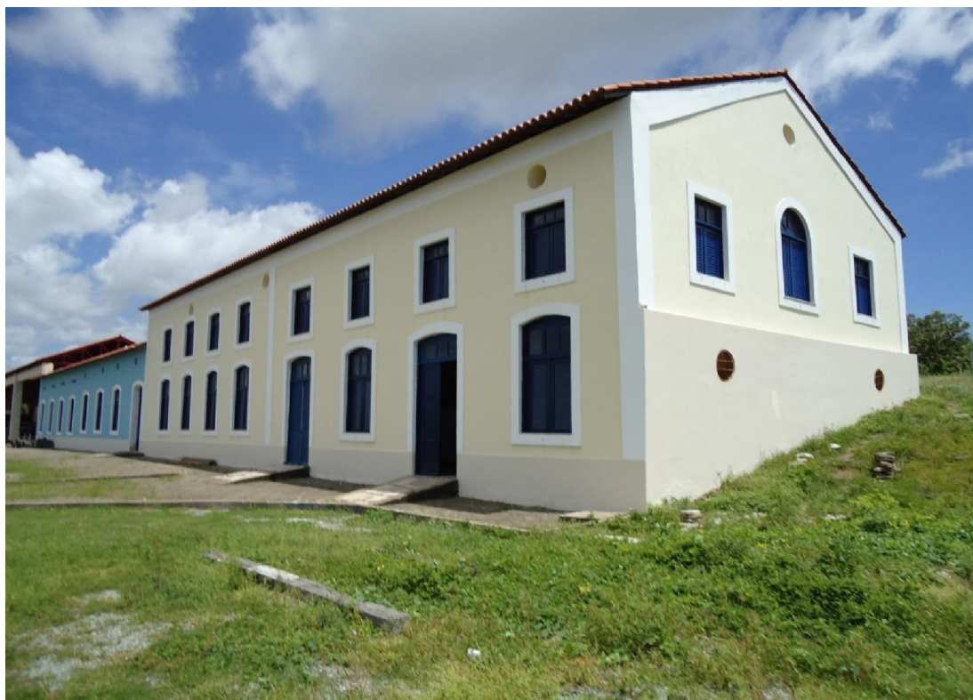
Foto 2 – Fachada do Setor Museográfico do CVT Estaleiro-Escola.
