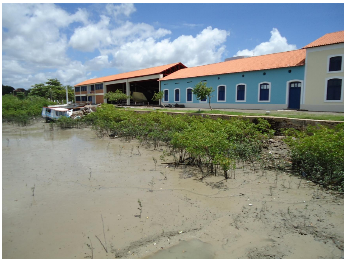
Foto 20 – Vista geral do CVT Estaleiro-Escola.
