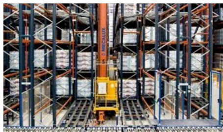
Transelevador en almacén automático.
